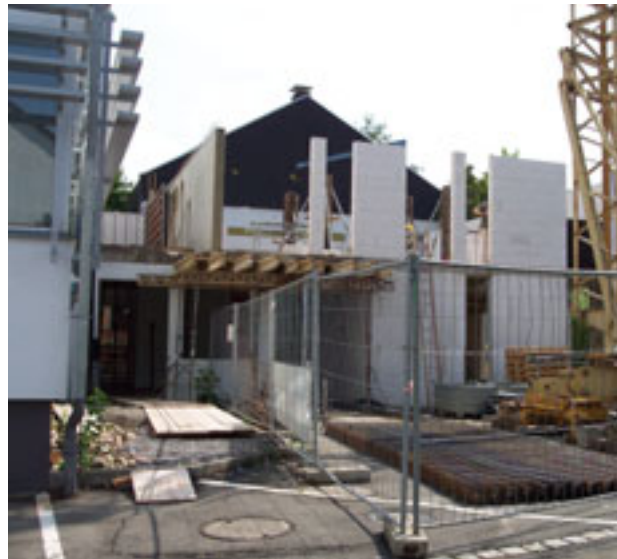
Der Rohbau entsteht
