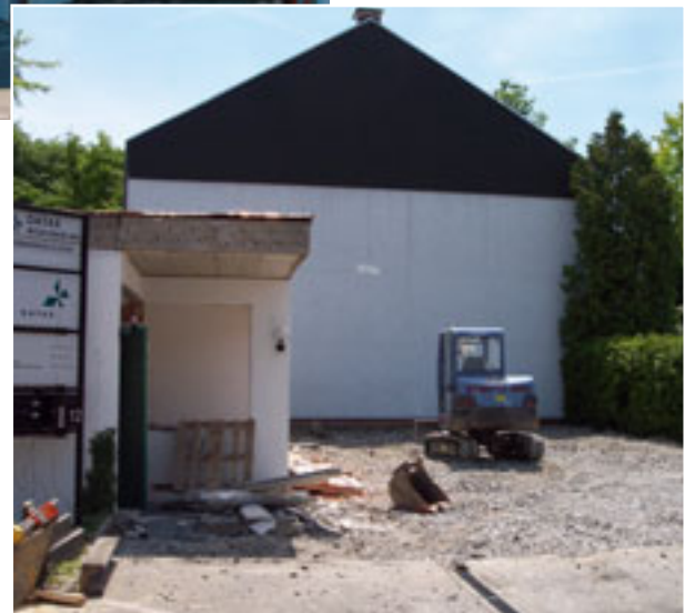
Beginn der Bauarbeiten im Juni 2006
